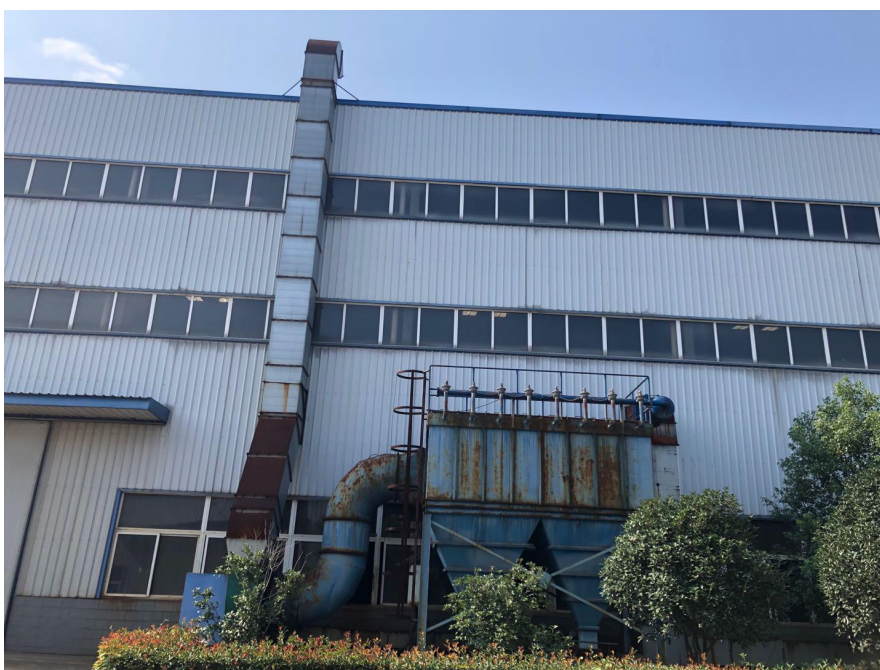
图 4-7 机加工粉尘处理设施图
