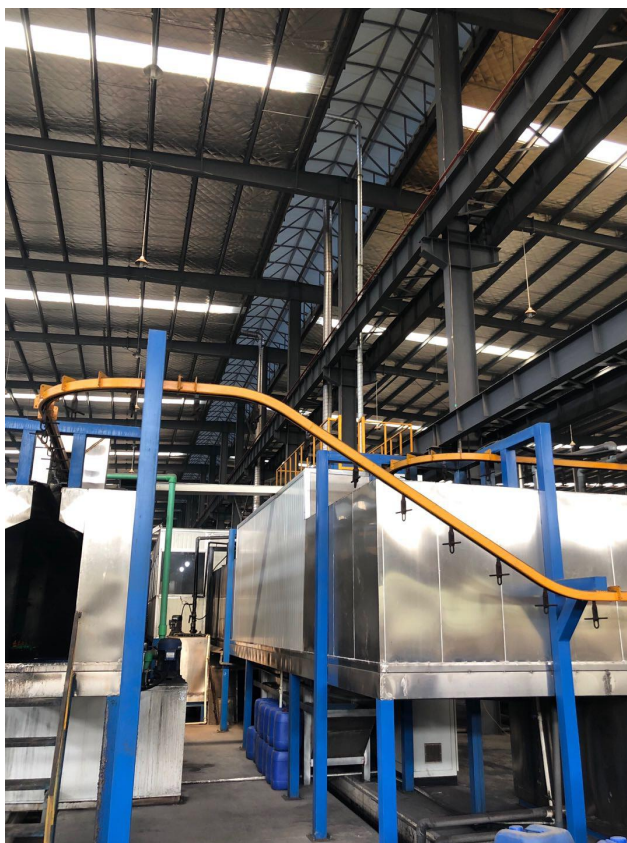
图 4-6 电泳烘干 15m 排气筒图
